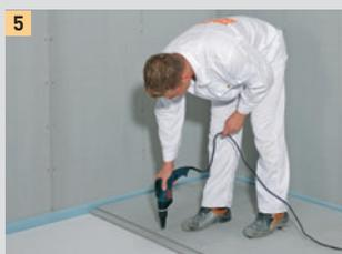
5 Assembler avec les vis Powerpanel...
